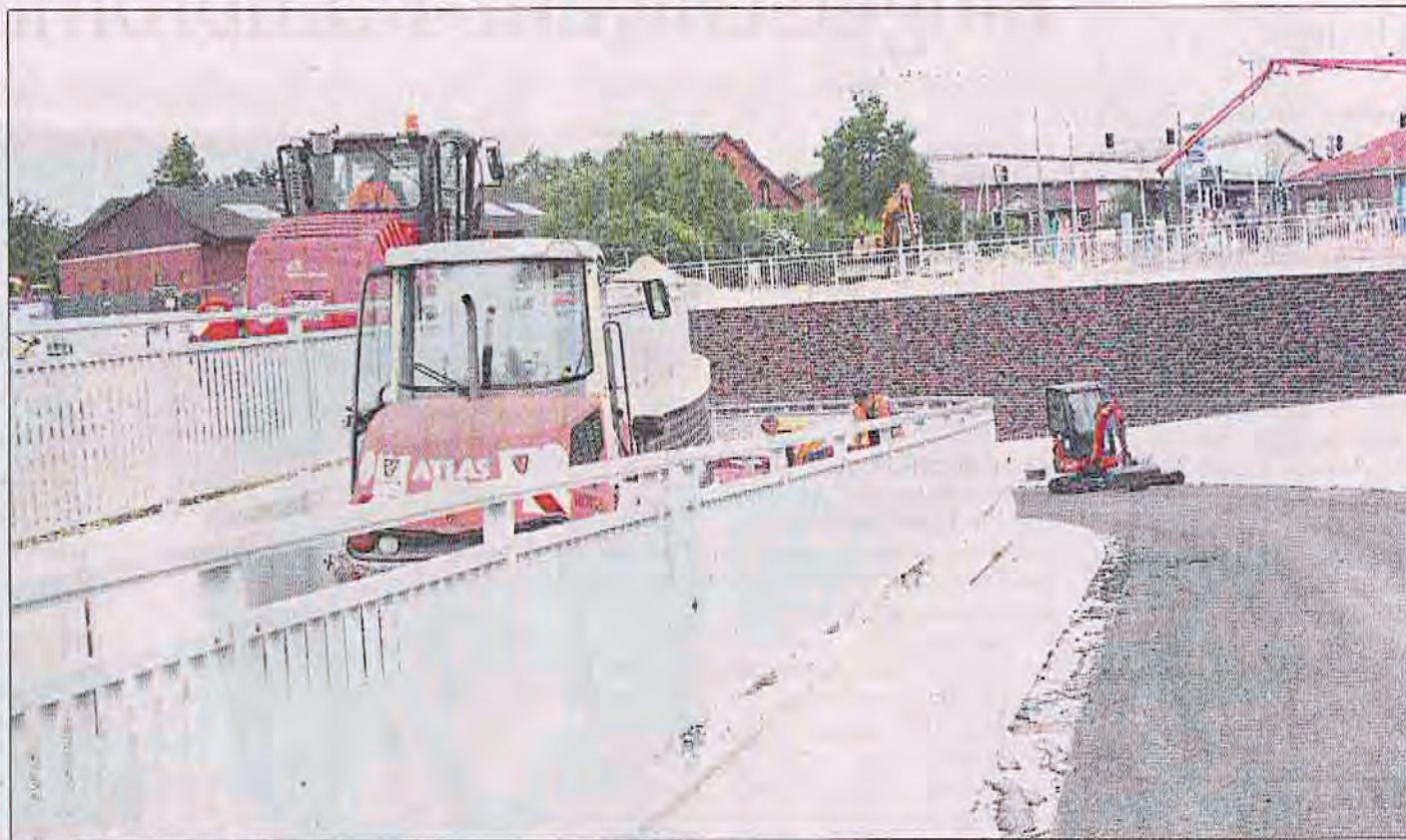
Noch sind nur Baufahrzeuge im Bereich der Unterführung zu sehen: Bald schon kommen die ersten Autos.
