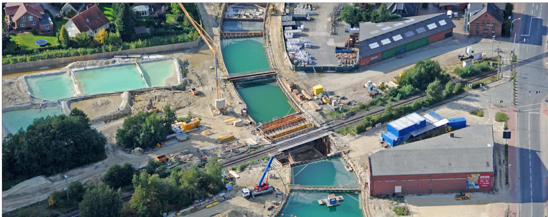
Grün und türkis schillert das Wasser in den Gruben der Baustelle Entlastungsstraße Vechta West. Das Bauwerk mit der endgültigen Eisenbahnbrücke ist oberhalb der Bahnstrecke zu sehen. In der Sperrpause wird es unter die Bahnstrecke geschoben. Aktuelle Bilder gibt es im Internet unter http://vechta.webcam-profi.de . Foto: Hartjens
